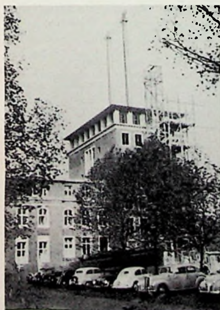
Richtfunk-Antennenmaste auf dem Verwaltungsgebäude der Hibernia-Bergwerksgesellschaft
